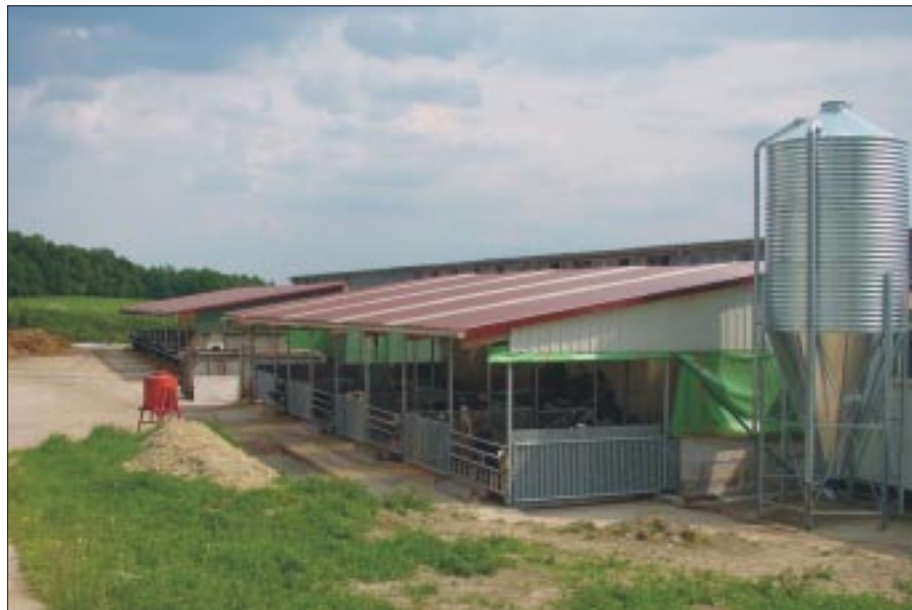
Im ersten der beiden untersuchten thüringischen Referenzbetriebe (Anlage A) werden die Kälber in einem Längsanbau am Stallgebäude untergebracht.
